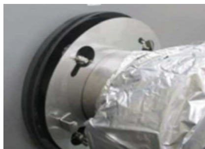
② ダクトの穴を固定ピンに合わせる
